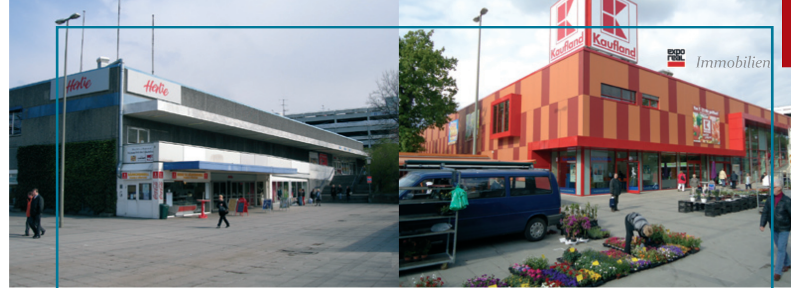
vor und nach der Revitalisierung: Hertie/Kaufland in Hamburg-Langenhorn
