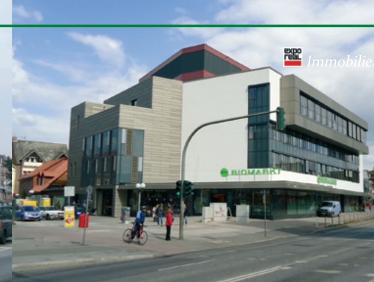
vor und nach der Revitalisierung: Neuer Mohnhof in Hamburg-Bergedorf (beide Seiten)
