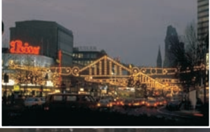
1980 Berlin 45m breite Lichtdächer mit über 1500 Fassungen, ausgestattet mit 7 Watt Glühlampen
