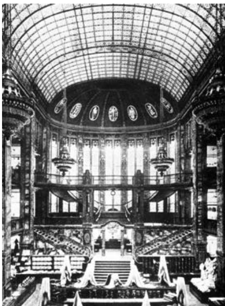
Kaufhaus Herman Tietz am Alexanderplatz in Berlin-Mitte, Lichthof im 2. Erweiterungsbau von 1911
